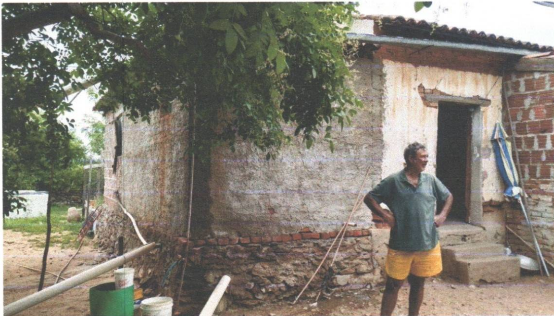
FOTO 01: CASA 1 – LOCAL DE CONSTRUÇÃO DO BANHEIRO NOVO
